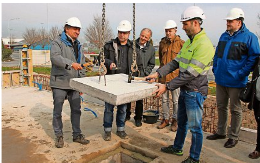
Mit drei Hammerschlägen wurde die traditionelle Grundsteinlegung des Rhyboot-Neubaus in Altstätten von Meinrad Gschwend, Leiter der Baukommission, René Schulze, Projektleitung und Marcel Ender, Bauführer, besiegelt.
